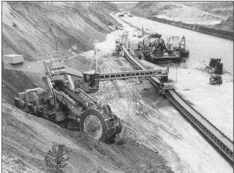
**Figure 4 – Creusement du canal Albert à Vroenhoven (partie la plus basse du canal) (photo: Grensschap Albertkanaal)**
